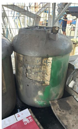
Depósitos para recogida de desechos oleosos de embarcaciones deportivas
