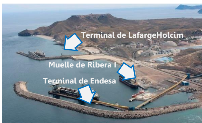
Instalaciones del Puerto de Carboneras
