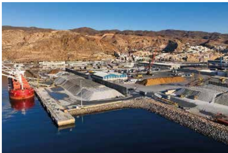
Muelle de Pechina en el Puerto de Almería
