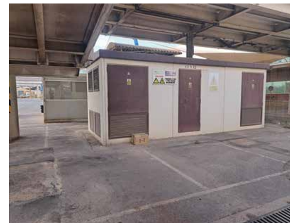
Localización de paquete sospechoso abandonado en Zona Internacional
