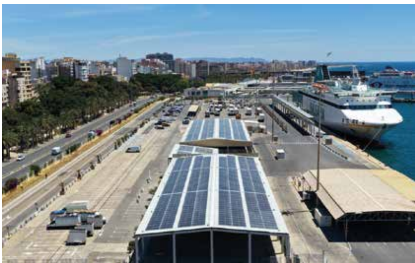
Placas solares Muelle Ribera I del Puerto de Almería
